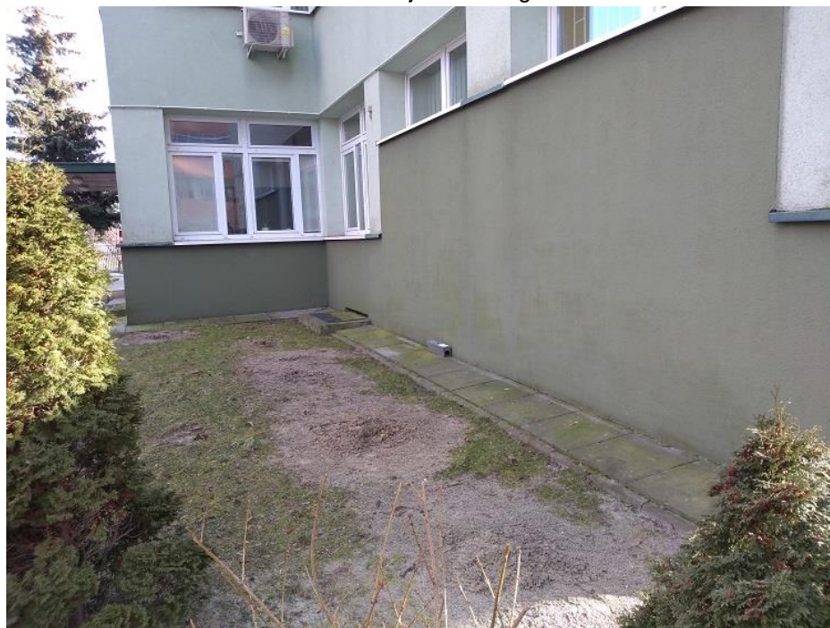
Fot. 2. Elewacja E1 – fragment
