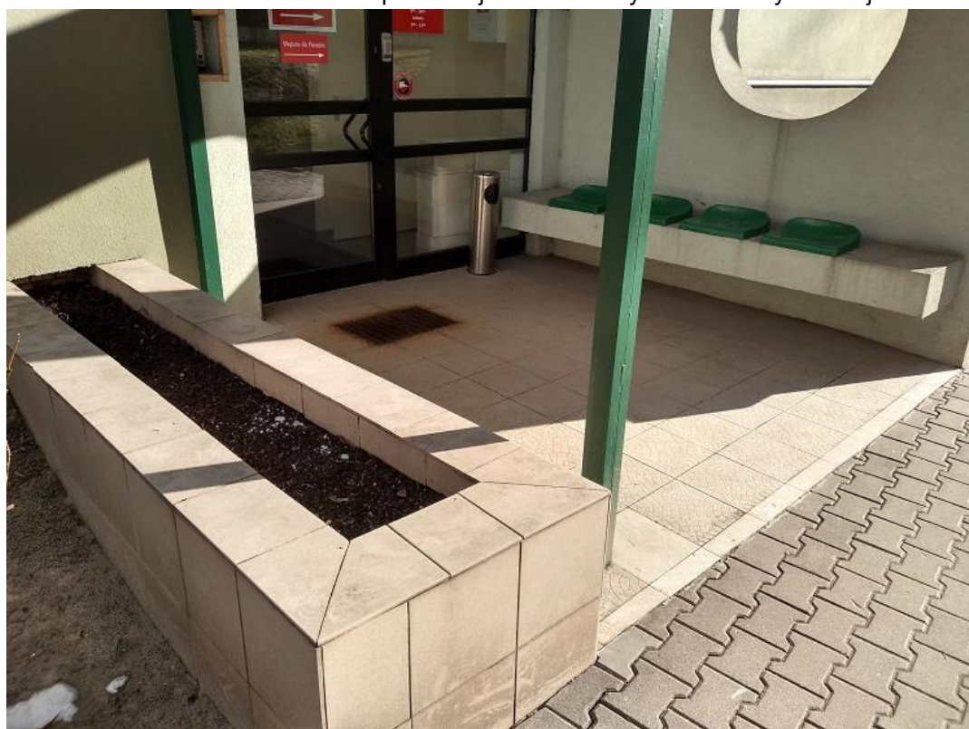
Fot. 12. Podest przed wejściem do budynku od strony elewacji E2
