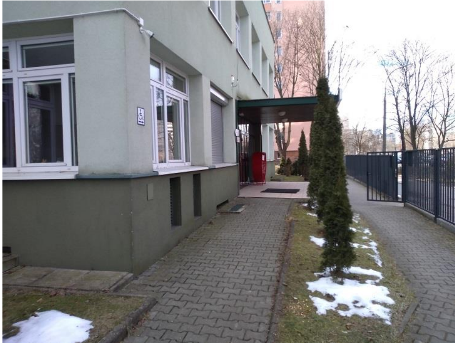
Fot. 1. Elewacja E1 – fragment
