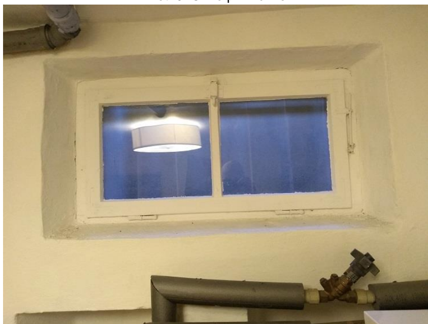
Fot. 10. Okno piwniczne
