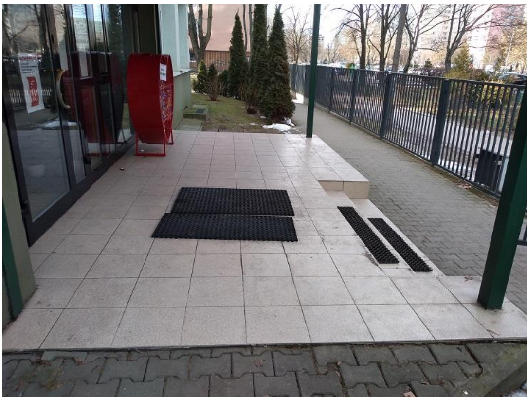
Fot. 11. Podest ze schodami przed wejściem do budynku od strony elewacji E1
