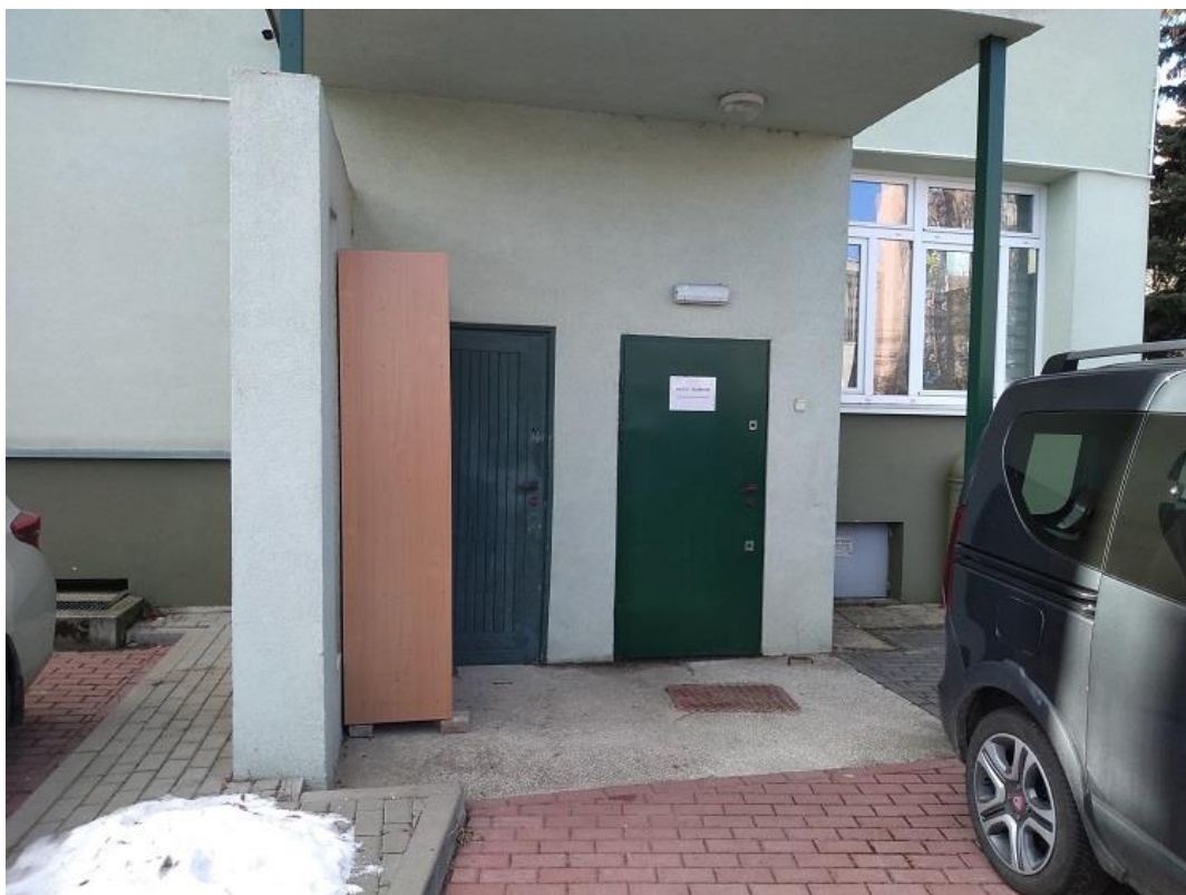
Fot. 13. Podest przed wejściem do budynku od strony elewacji E4
