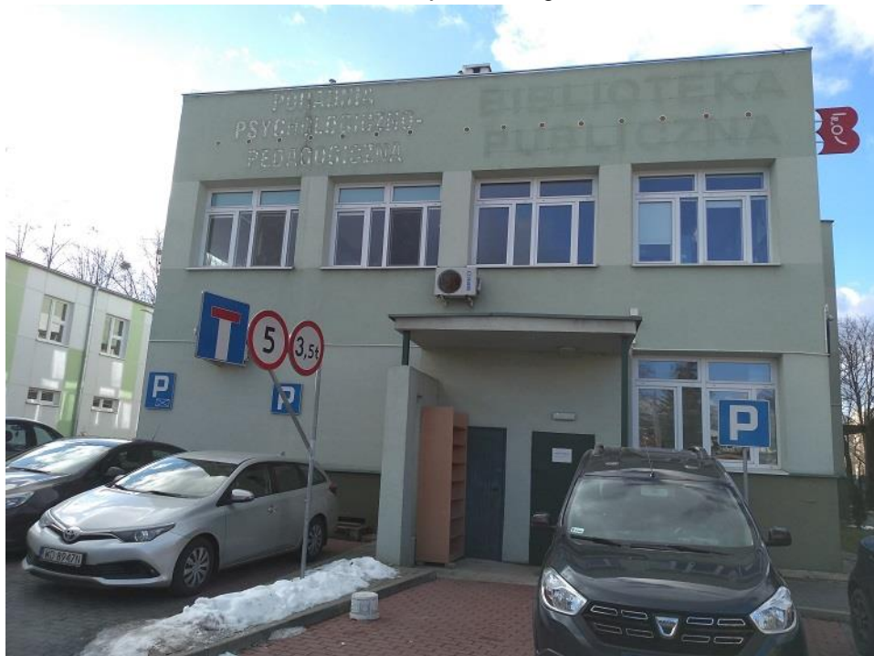
Fot. 6. Elewacja E4
