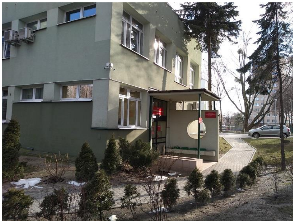
Fot. 3. Elewacja E2
