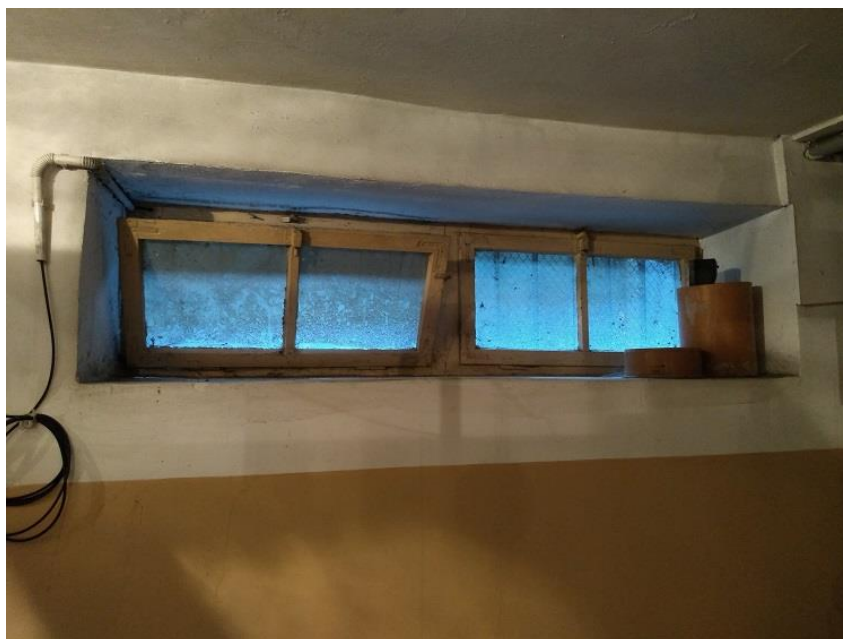
Fot. 9. Okno piwniczne
