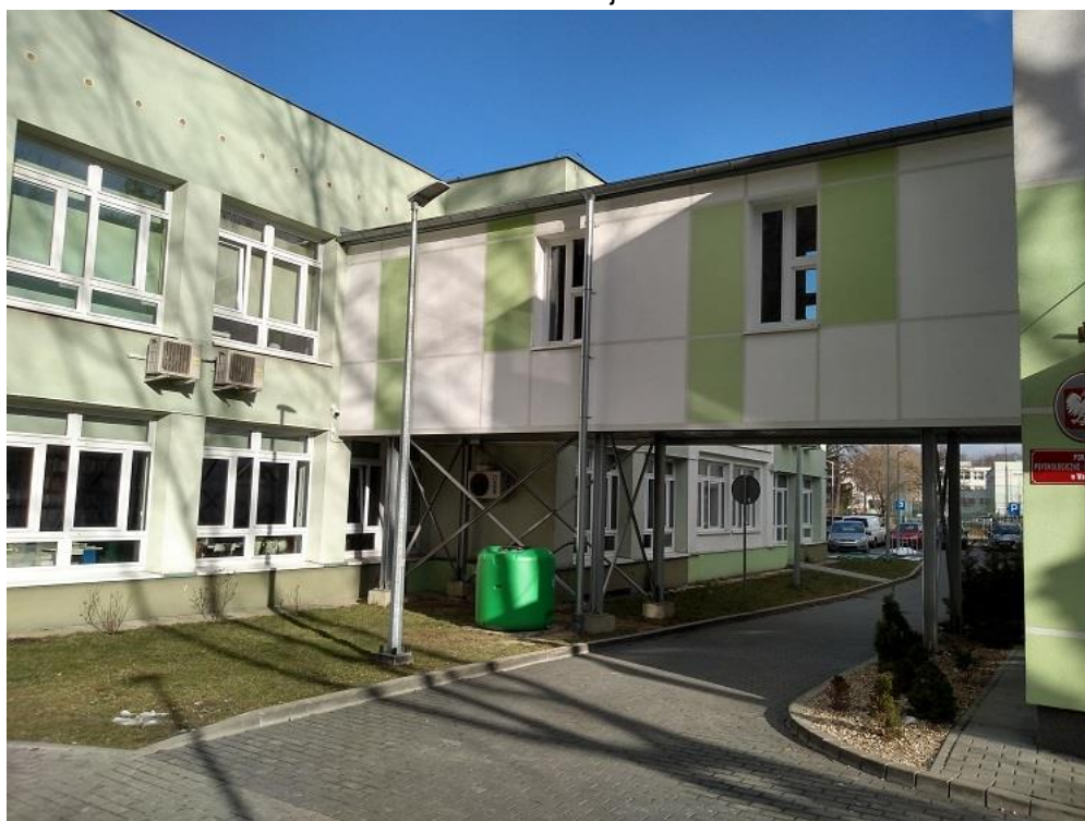
Fot. 4. Elewacja E3 – fragment, widok na łącznik
