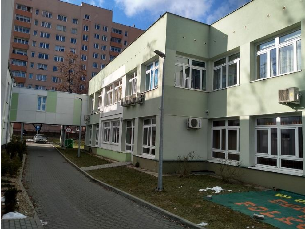
Fot. 5. Elewacja E3 – fragment
